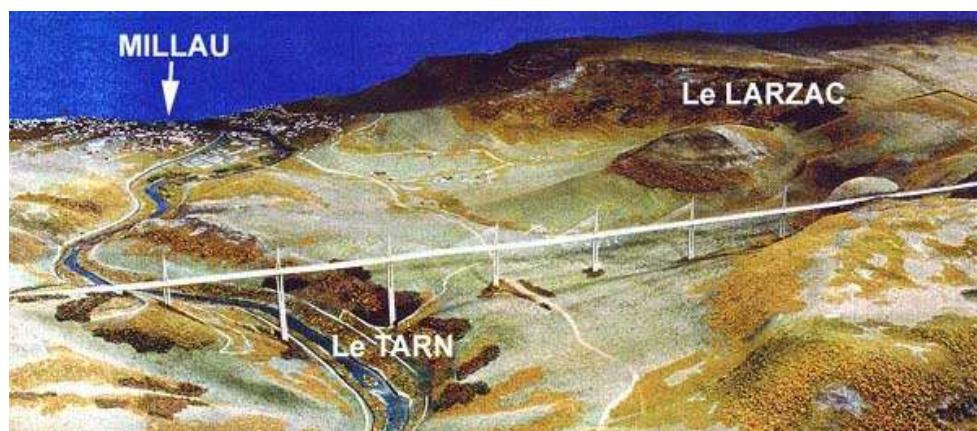
L'ensemble pile-pylone le plus élevé culmine à 340m, aussi haut que la Tour Eiffel. La construction de l'ouvrage a nécessité environ 127 000 mètres cubes de béton, 19 000 tonnes d'acier de béton armé, 5000 tonnes d'acier de précontrainte ( câbles et haubans ).
